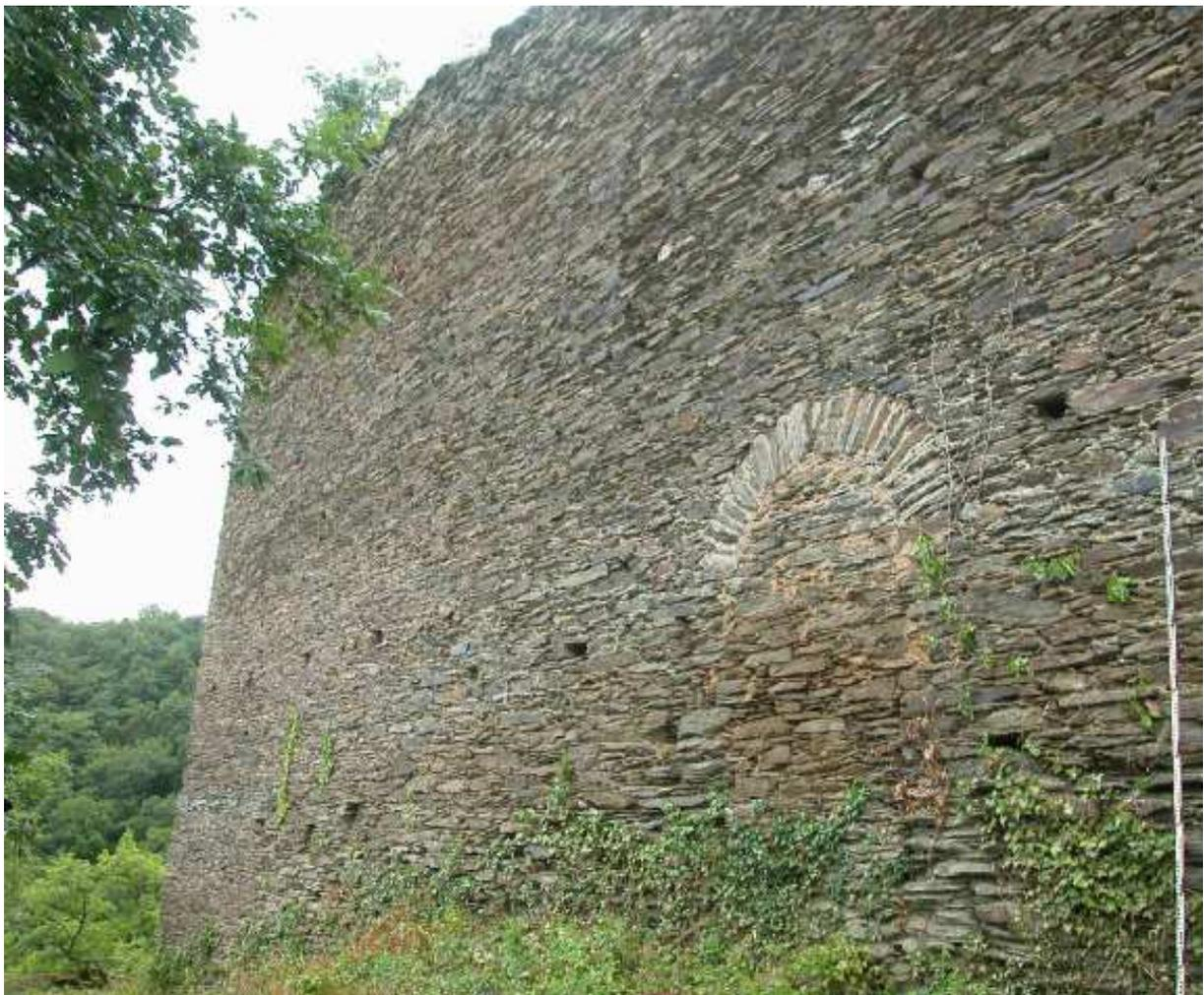
Abb. 6: Rauschenburg, Ansicht der gegen Südosten gerichteten Mantelmauer mit dem später vermauerten ursprünglichen Eingangstor (siehe Fig. 4). Rechts oberhalb ist die Baunaht von Befund (24) zu erkennen.
