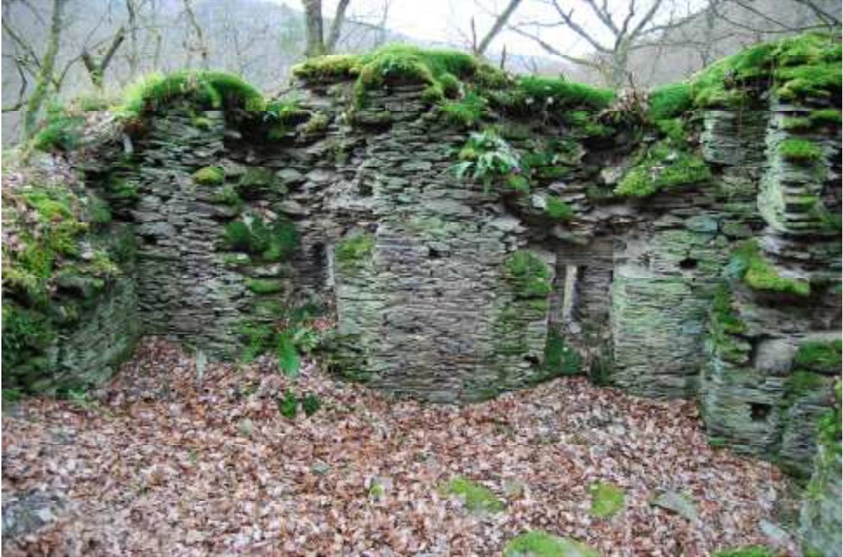
Abb. 13: Burg Waldeck, Blick in das Untergeschoß des Burghauses (23) mit zwei zum Tal ausgerichteten Lichtschlitzen und der verriegelbaren Tür zum Vorglände (rechts).
