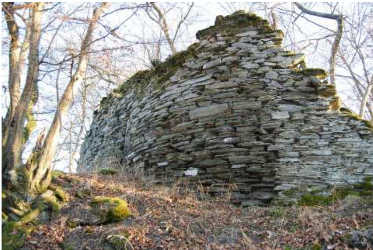
Abb. 14: Burg Rheinberg, Stumpf des runden Nordturmes mit darin angebauten Mauerschenkeln. Außenseite Blick richtung Ost. (Aufnahme: Verf.asser)
