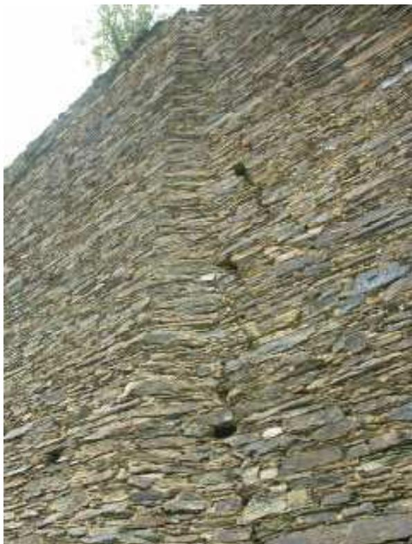
Abb. 8: Anschluss der südlichen Ringmauer an die Schildmauer
